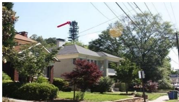
Fig. 13. Antene GSM instalate și camuflurate în copaci-sursa internet
